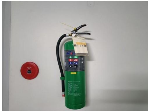
รูปที่ 2-29 ถังดับเพลิงแบบมือถือ พร้อมคำแนะนำการใช้งาน
